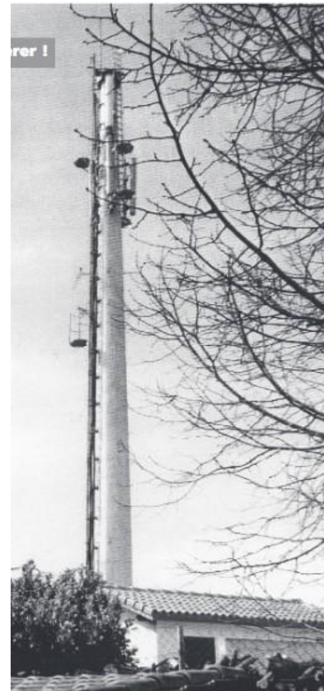
Occitanie: antenne de 30m de haut à 6m d'une maison
